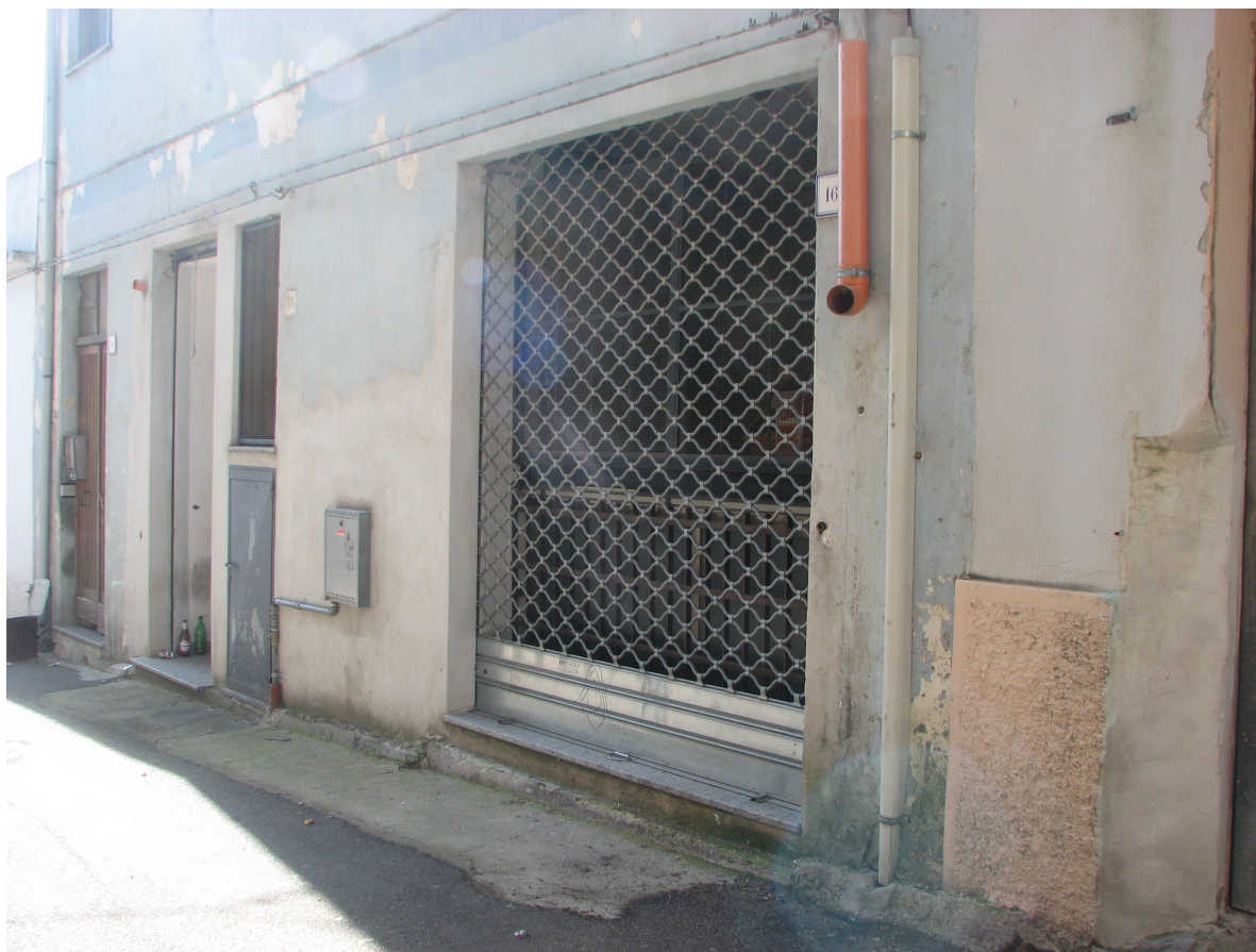
Viste ingresso dalla Via Tempio
